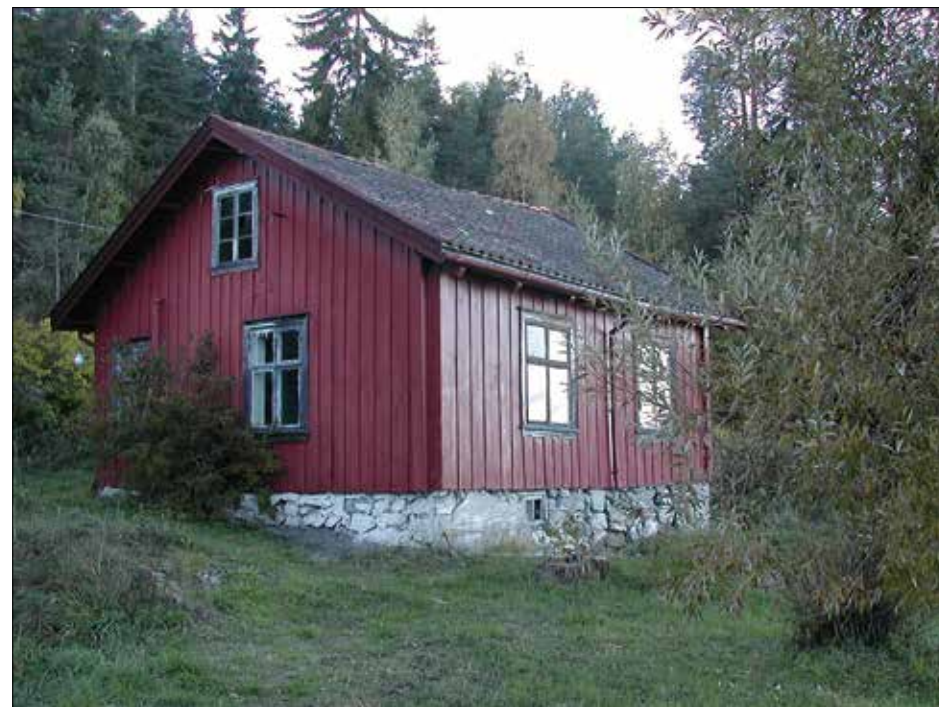
Husmannsplassen Grøstadstrand ble satt opp rundt århundreskiftet 1700–1800. I 1998 ble huset rehabilitert på dugnad, og brukes nå i undervisningen ved Jaer skole.
