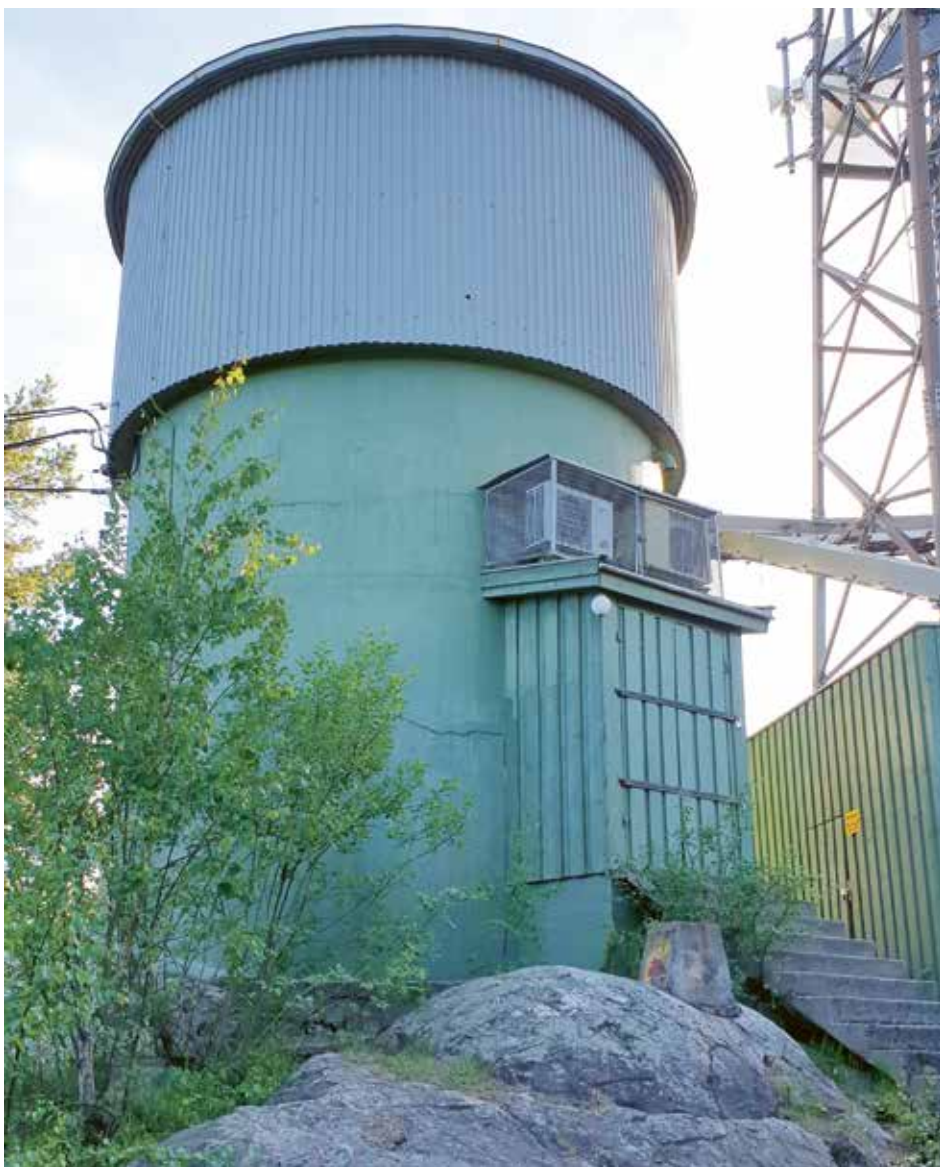
Det gamle navigasjonstårnet med Televerkets nyere påbygg øverst.
