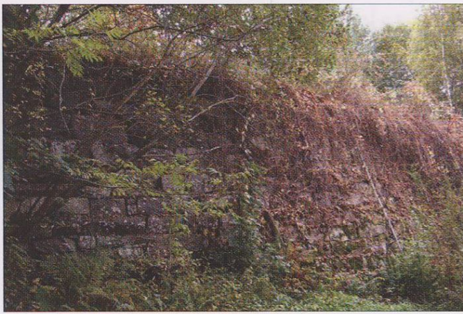
Demningsmuren ved Engsdammen.
