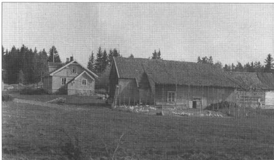
Slik så Myrene ut ca. 1940. Legg merke til fjøsveggen, den er laget av lange, tykke vedkubber og leire
